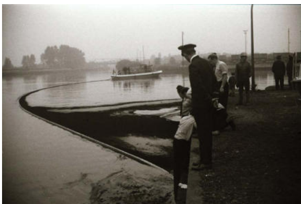
Die Ölsperre wird mittels FLB ausgelegt, Russ hatte sich am 22.10.1969 im Hafen Hardenberghafen ausgebreitet
