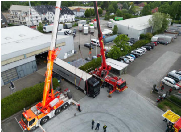
Aus dieser Engstelle musste der LKW im Tandemhub geborgen werden. (© Demmig)
