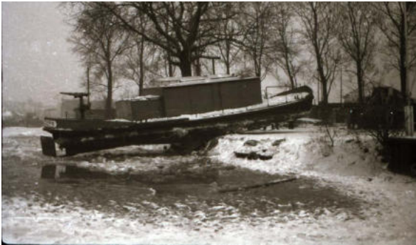
Mit dem Spill des KW15 wird das FLB 1 bei Eis aus dem Dortmund-Ems-Kanal gezogen
