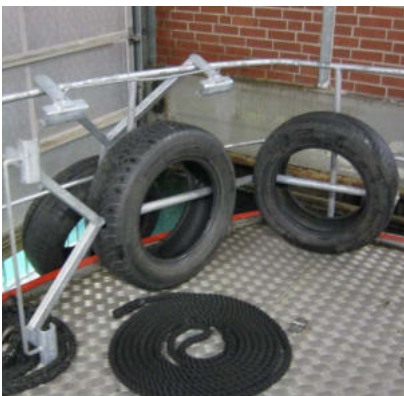
Anlegehilfen für die mit Steinen ausgebauten Uferbereiche
