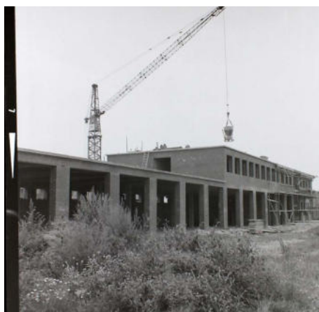
Rohbau der Wache
