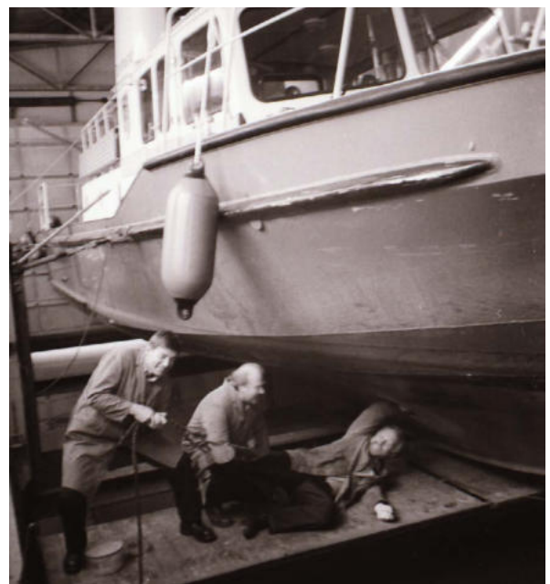
Das FLB3 ist im Hafenstützpunkt mit der Hebeanlage für Reparaturarbeiten aus dem Wasser gehoben
