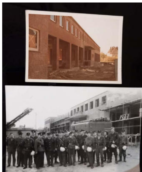
LZ22 vor dem Rohbau
