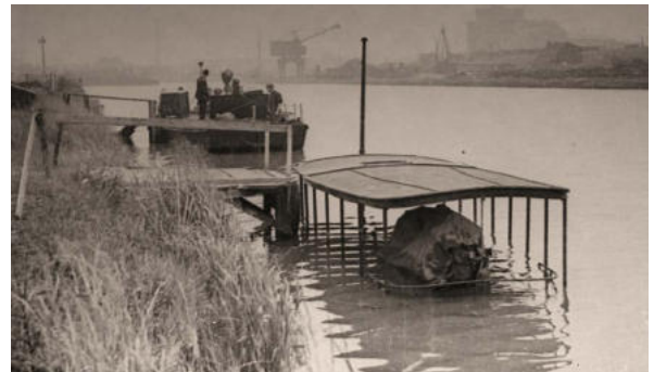
Versenkt, es schauen nur noch das Dach und eine mit Segeltuch abgedeckte TS auf dem Deck des FLB2 Reinoldus aus den Fluten des Dortmund-Ems-Kanals
