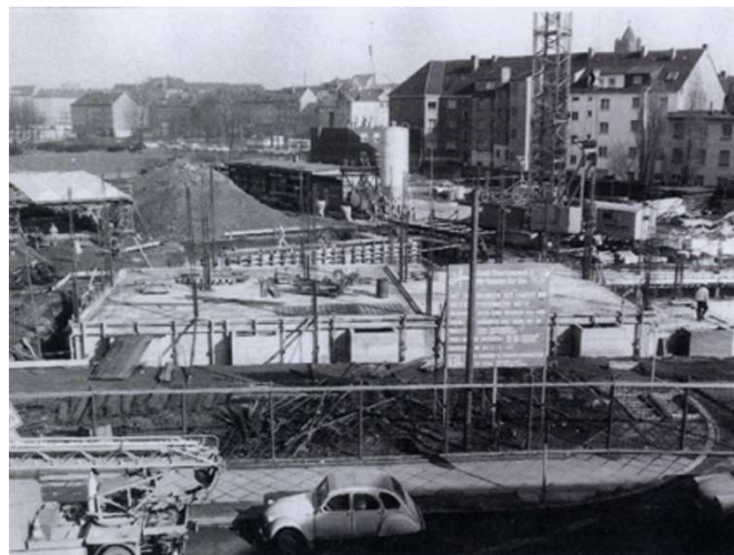
Neubau der Feuerwache 1 an der Steinstraße
