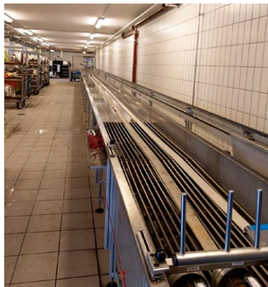
Schlauchprüfung – Sicht auf den Schlauchtisch
