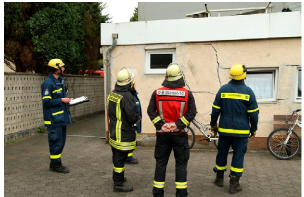
Abb. 2: Begutachtung von Rissen an einem Gebäude
