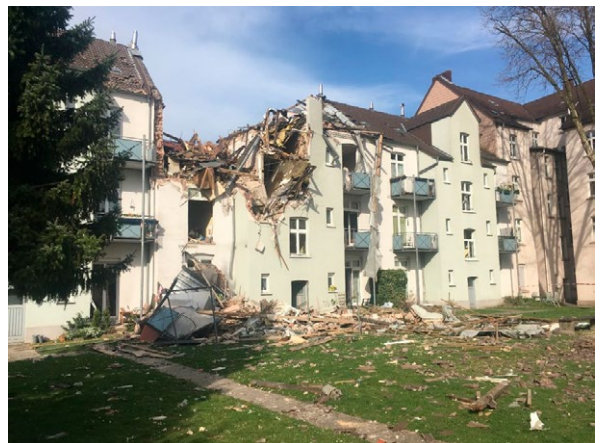
Abb. 3: Verlust von tragenden Wänden (Foto: Feuerwehr Dortmund)
