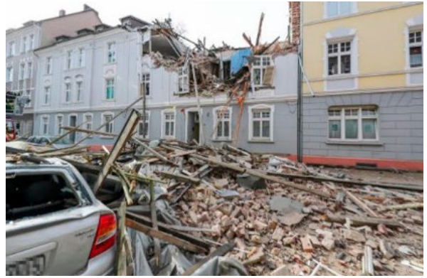
Abb. 1: Massive Zerstörung der Gebäudestruktur nach einer Explosion (Foto: Feuerwehr Dortmund)
